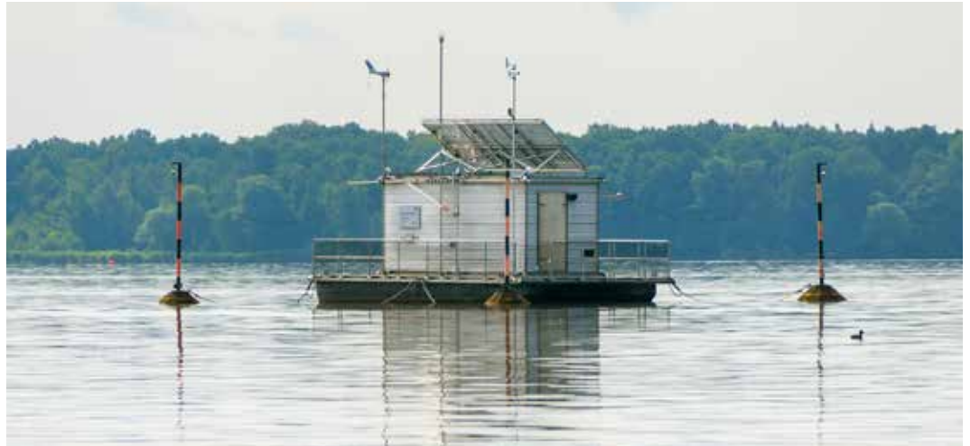
Bereits seit über 45 Jahren wird an der Messstation auf dem Müggelsee automatisiert die Wassertemperatur an der Oberfläche und in fünf Metern Tiefe gemessen.
