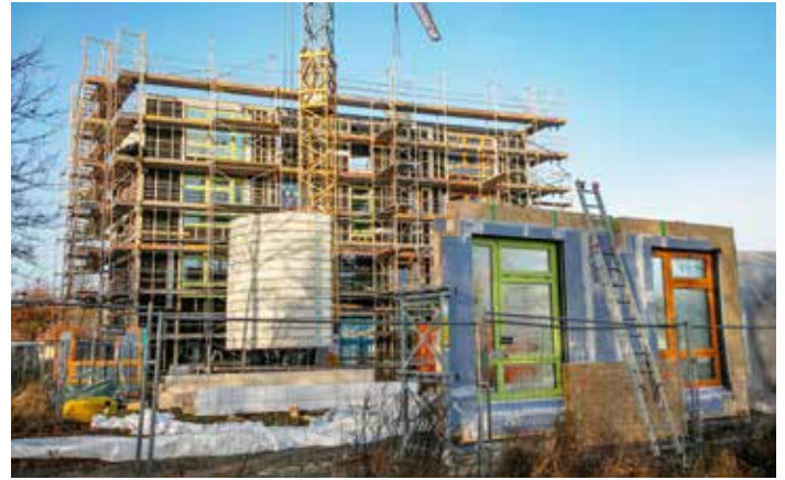
Eines der höchsten Gebäude Schöneiches wächst planmäßig: Die neue Kita an der Schillerstraße
