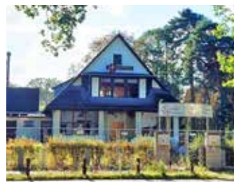
Mittlerweile ist der Tannenhof abgerissen
