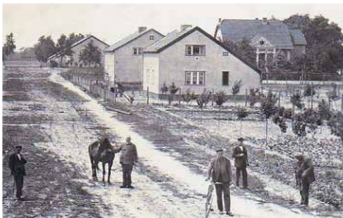
Die Invalidendank-Siedlung im Aufbau vor 100 Jahren – inklusive der Villa des ehemaligen Besitzers der Spargelplantage.
