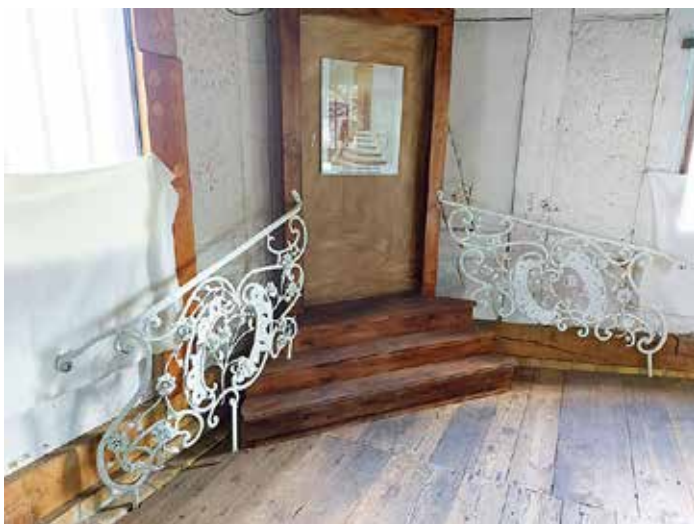
Alte Treppengeländer aus dem Schloß im Raufutterspeicher
